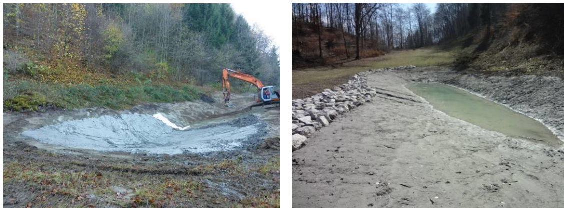
Figure 15. Etang en construction, pose de l'étanchéité / Etang en cours de remplissage
