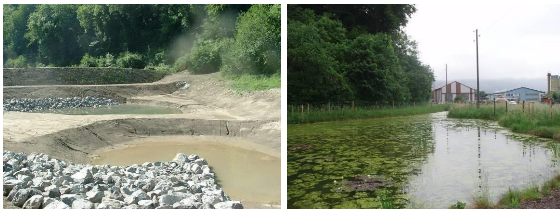
Figure 5. Etang des Ilettes en construction (06.2005) / après aménagement (06.2008)
