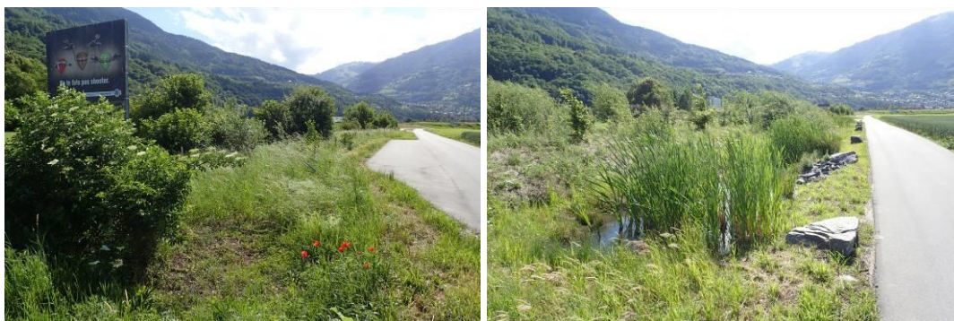
Figure 1. Rideau-abri le long de la T37 : Etat des plantations et d'une des mares pluviales en juillet 2017
