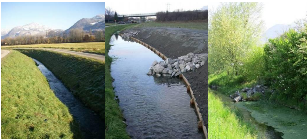
Figure 4. Canal des Iles (état initial, 10.2007) / travaux d'élargissement (04.2008) / développement de la végétation (04.2014)
