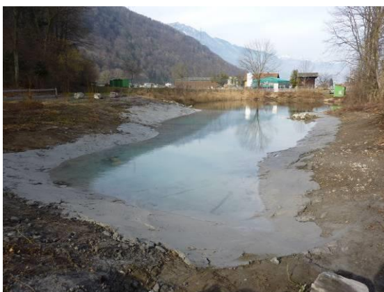
Figure 8. Abaissement et étanchéification de la zone inondable, mars 2011 / Zone inondable, novembre 2012
